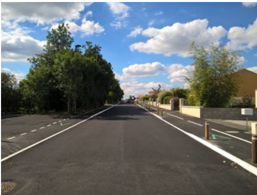
Travaux, Aigrefeuille-sur-Maine, Parcs d'activités 07/06/2017
