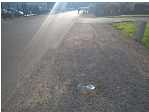
Travaux, La Haye-Fouassière, Site Aggloh, Site Habiter, Site Économie 04/10/2017
