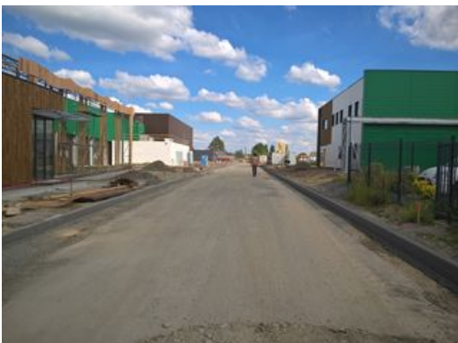
Travaux, Remouillé, Parcs d'activités 07/06/2017
